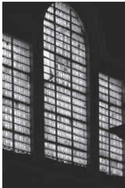
Fig. 1. Vidriera de 1655 (antes de la restauración)
